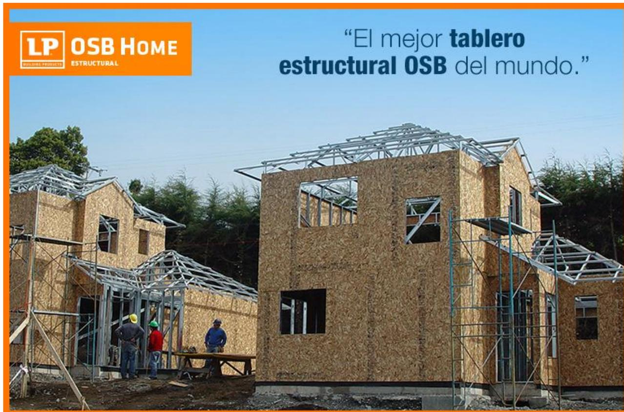
Los tableros **LP OSB**, son tableros estructurales de madera fabricados en Chile por Louisiana Pacific, líder mundial en **OSB**. Siendo ampliamente utilizados en la construcción de techumbres, muros y pisos, tanto en construcciones habitacionales y comerciales hasta 4 pisos.
